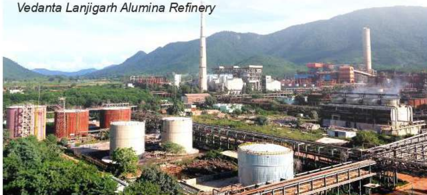
Vedanta Lanjigarh Alumina Refinery
